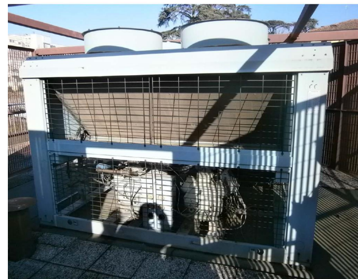
Gruppo frigo sostituito
